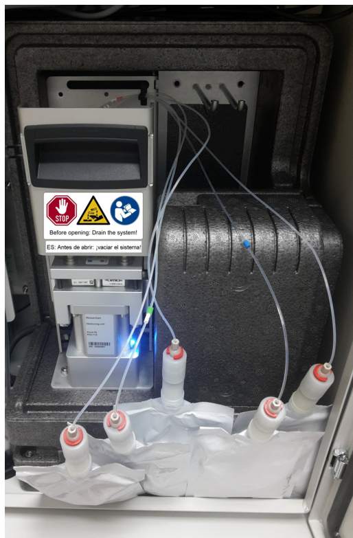
figura 5-7 ChemBag rimossa per la sostituzione
